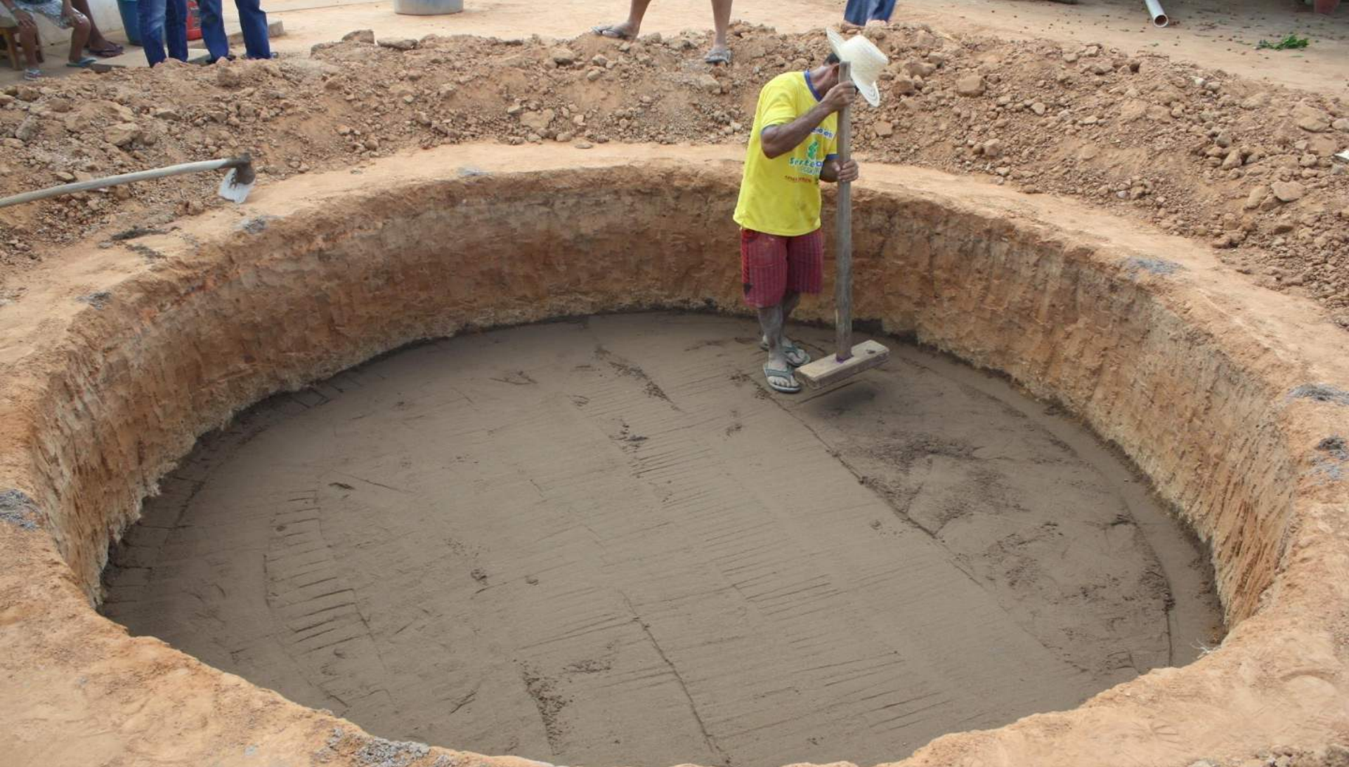
Nivelamento da Massa no Fundo do Buraco
