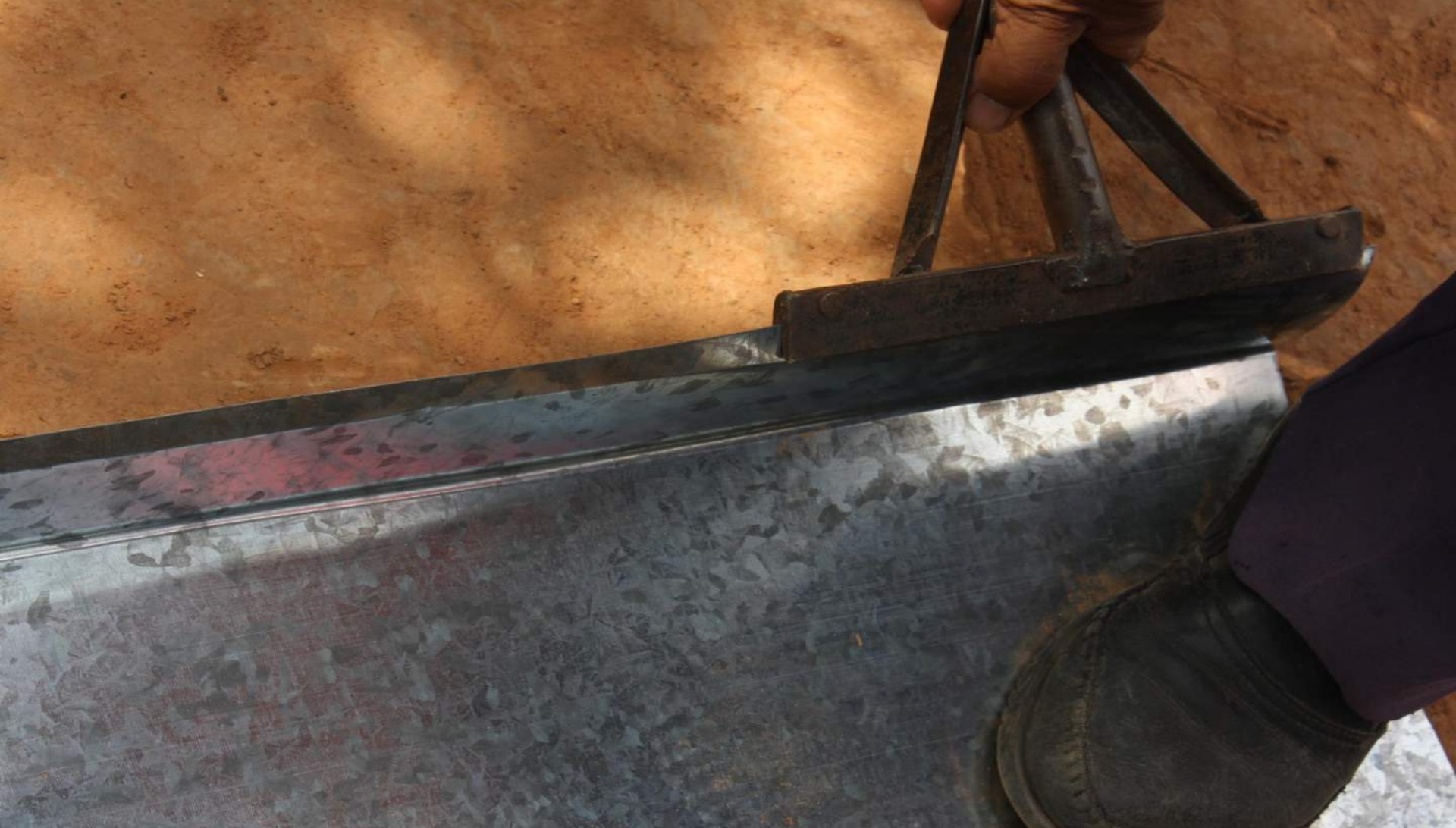
Dobramento da calha
