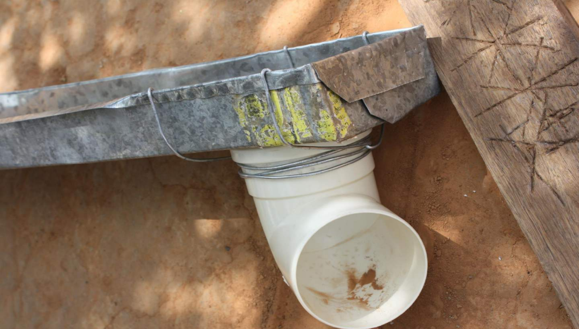
Joelho Instalado na Calha
