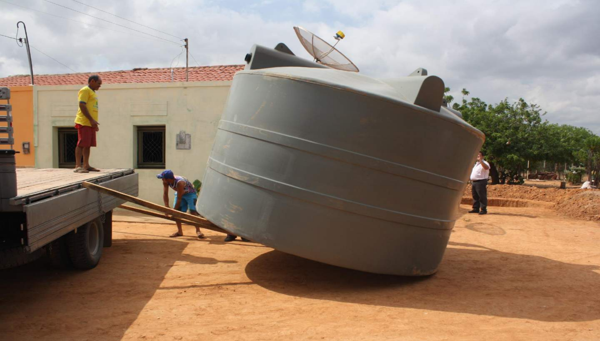
Descida da Cisterna
