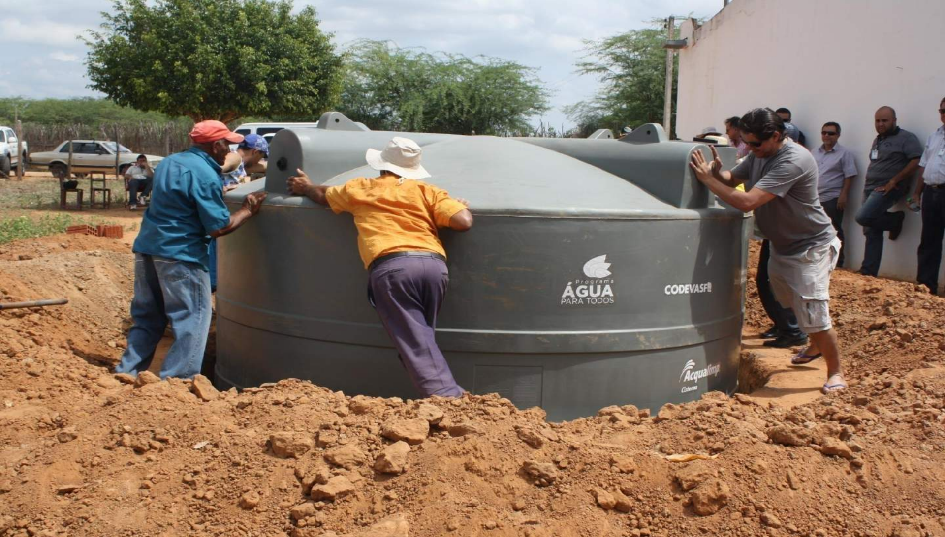
Busca de Posicionamento da Cisterna
