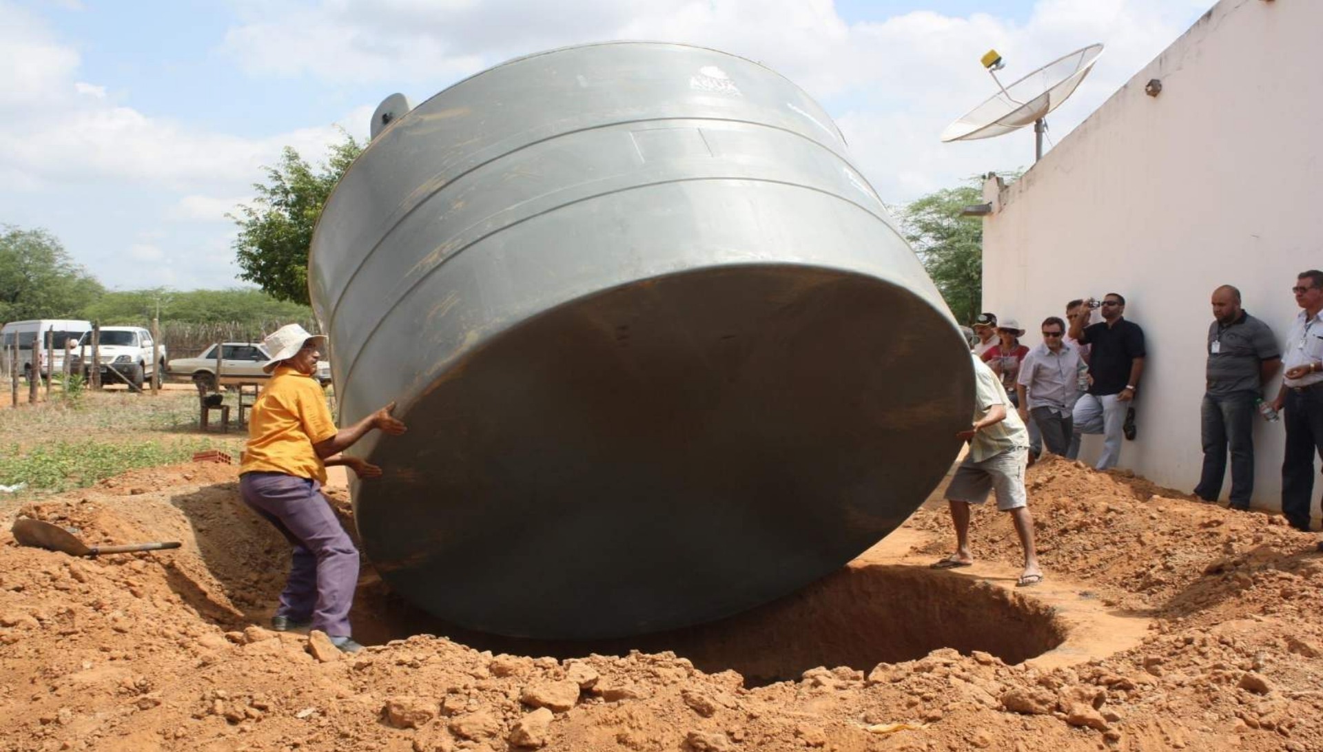
Colocação da Cisterna no Buraco
