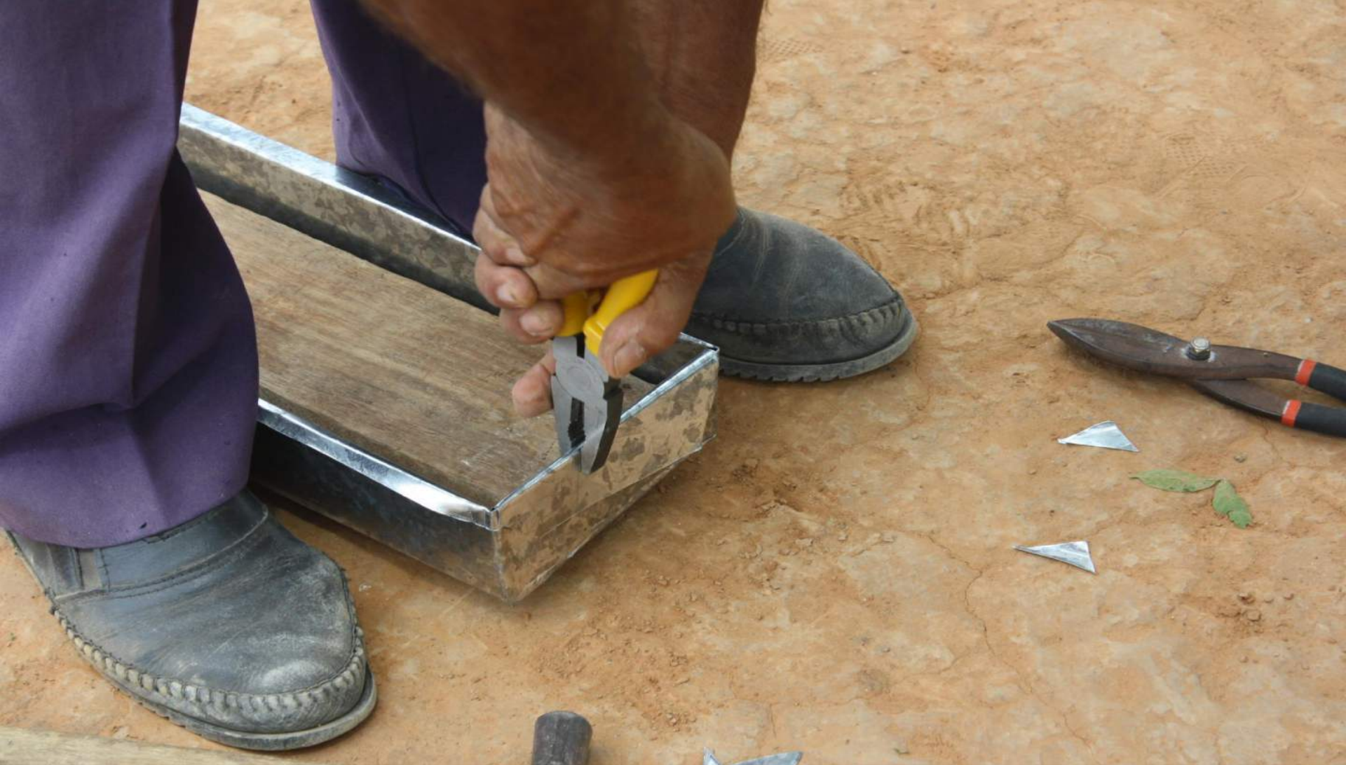
Dobramento da Calha
