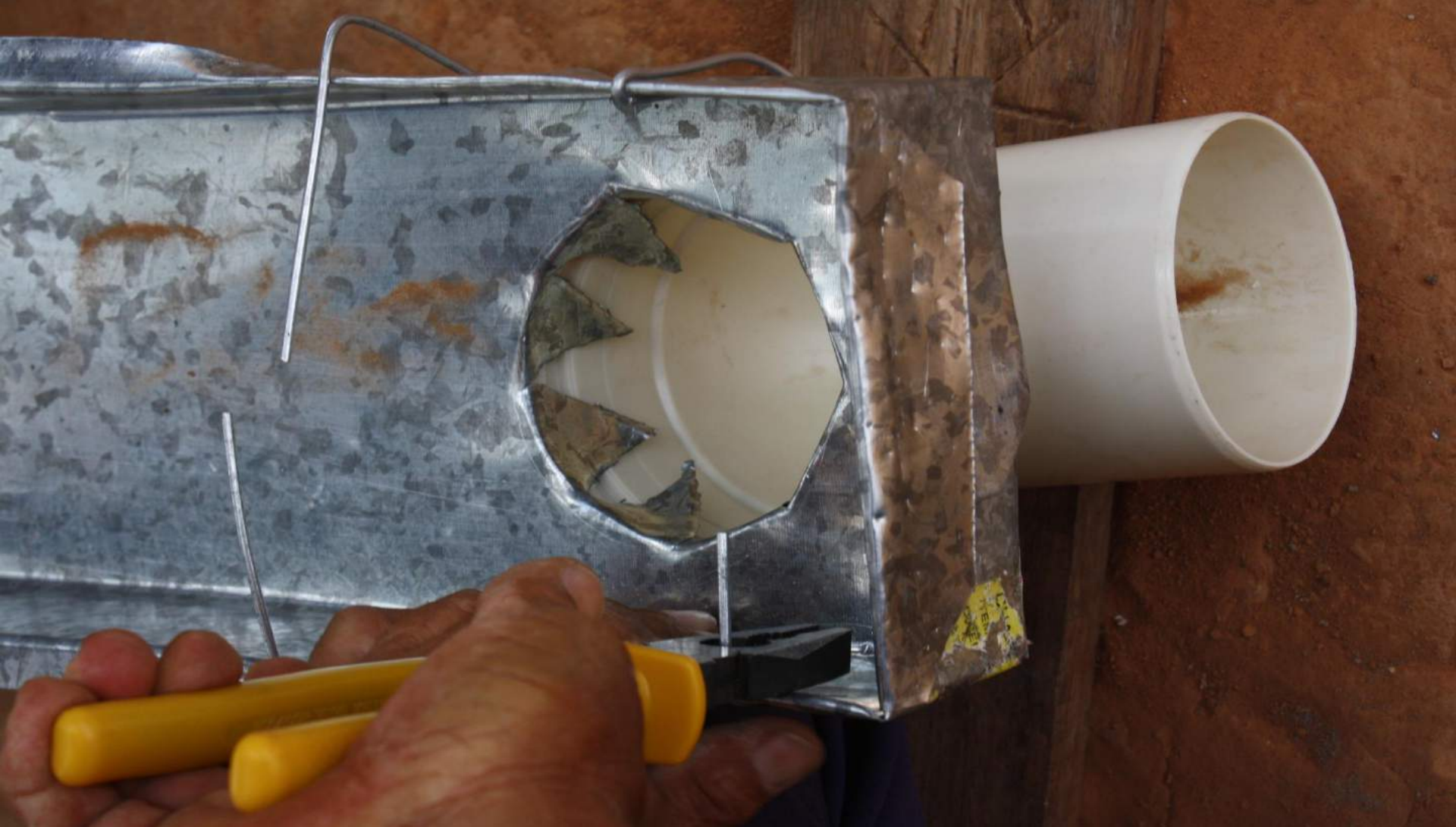
Amarração da Calha no Joelho do Cano
