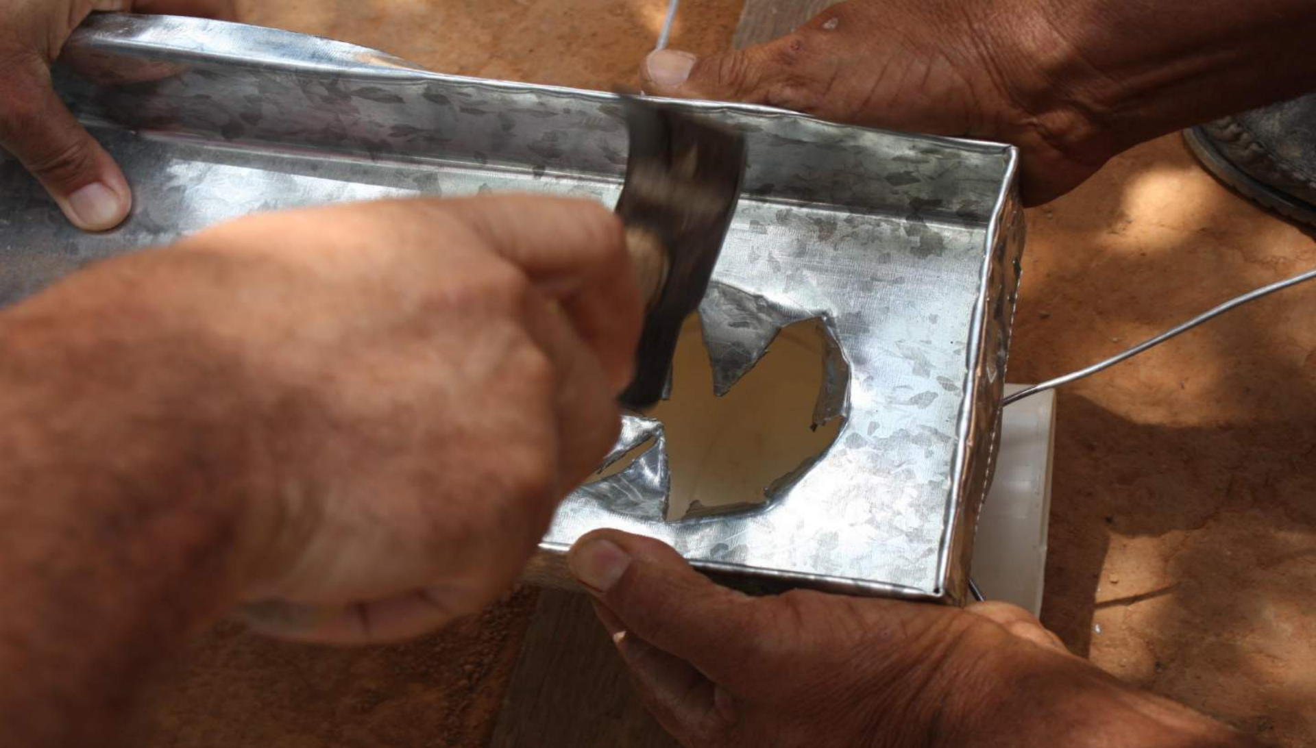
Abertura do Furo na Entrada do Cano
