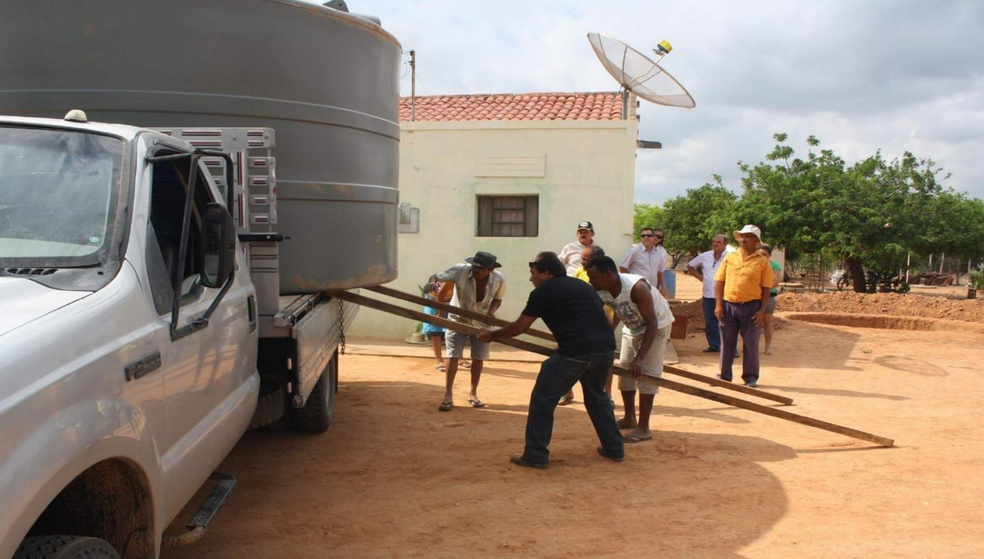
Descida da Cisterna do Caminhão
