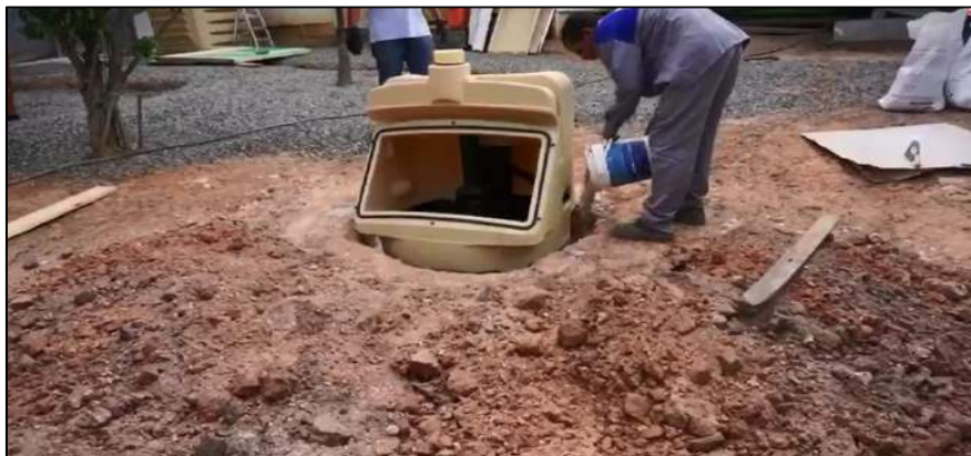
Reaterrar a lateral da unidade funcional.
