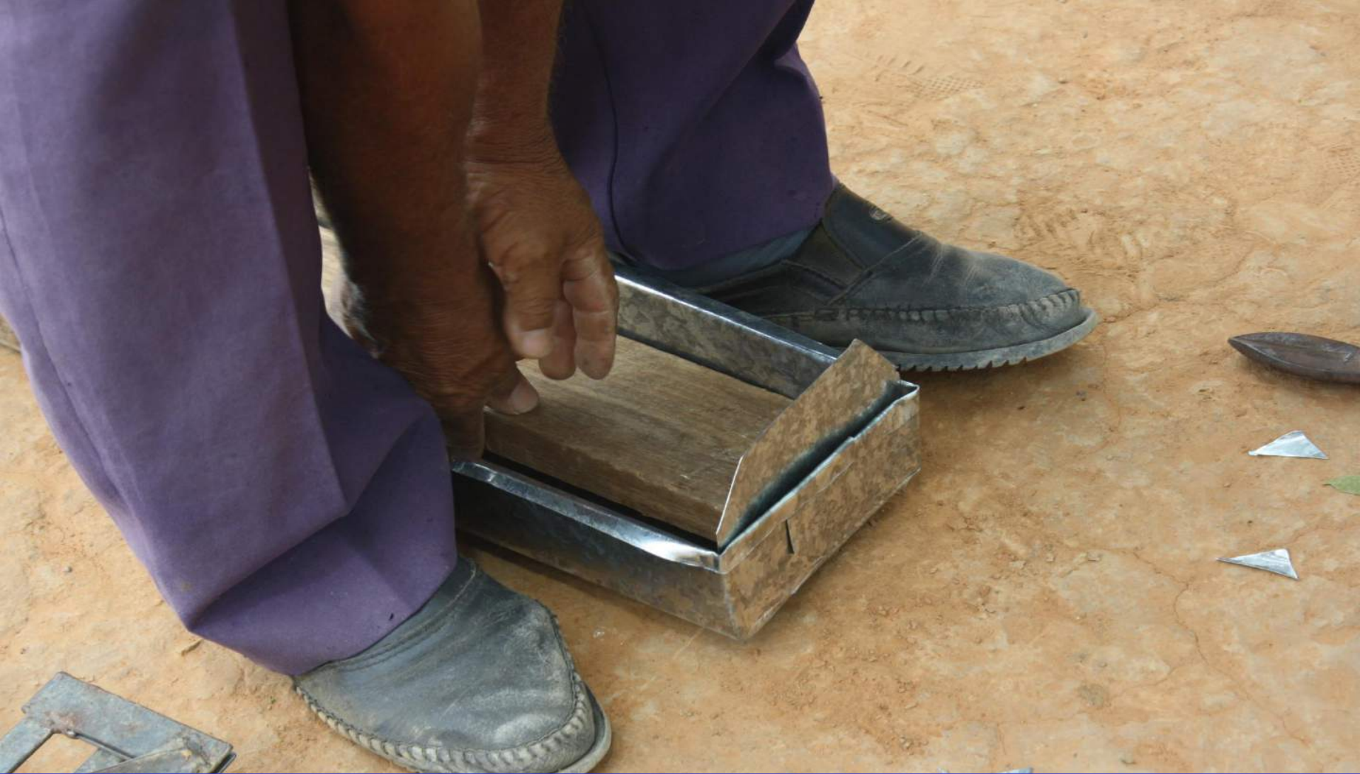
Dobramento da Calha
