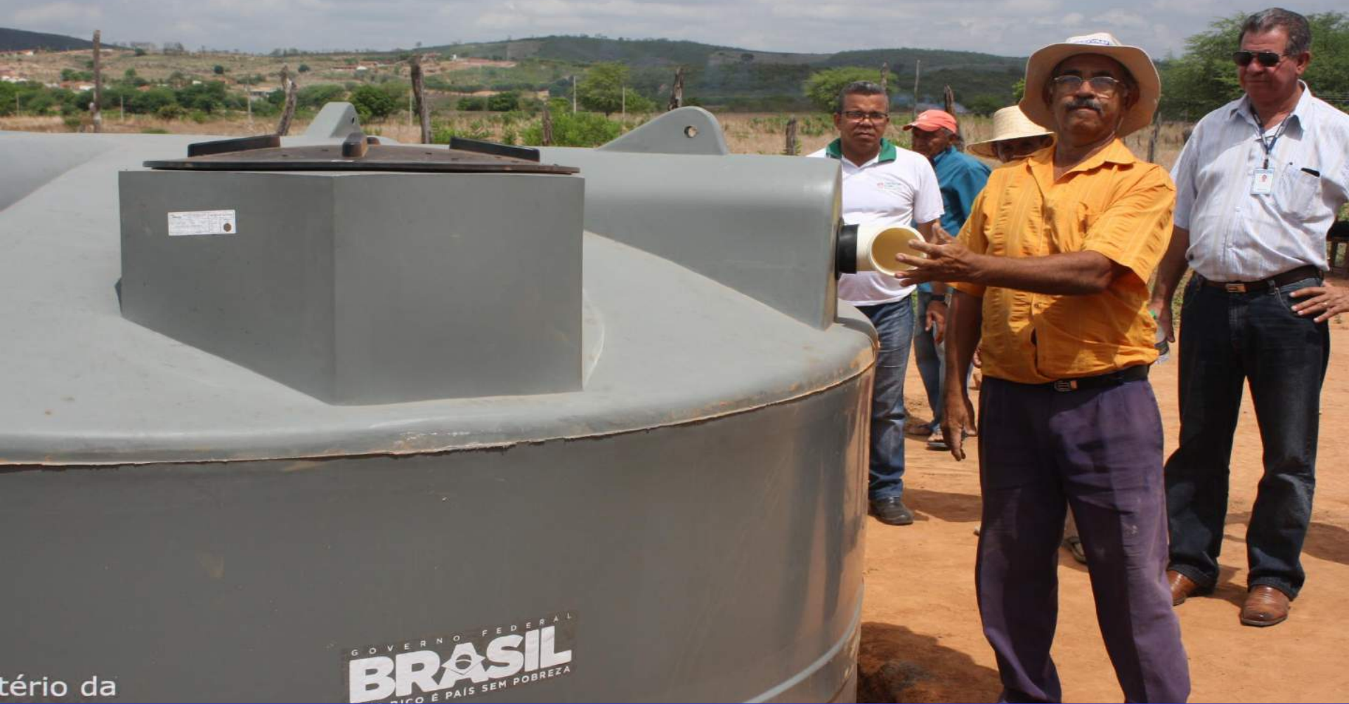
Entrada do Cano com Joelho Instalado
