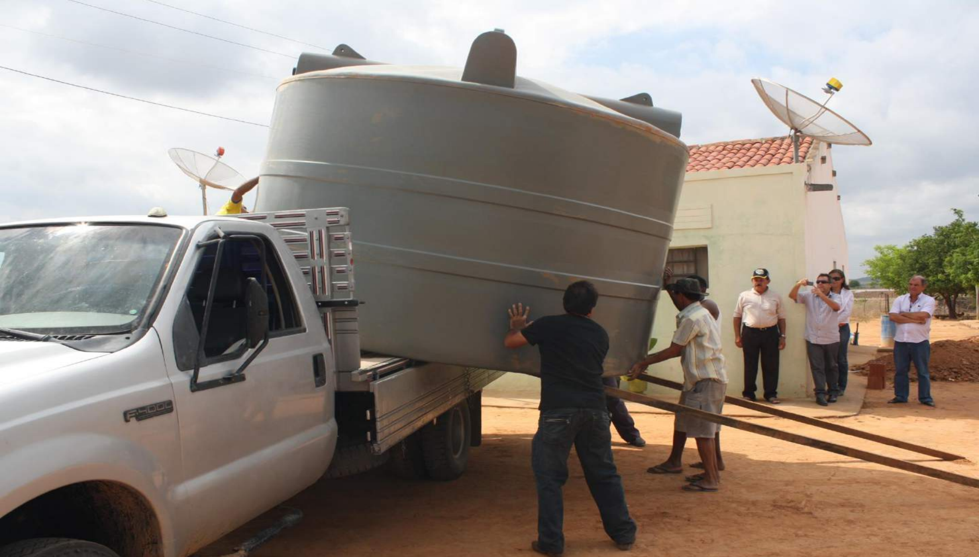
Descida da Cisterna
