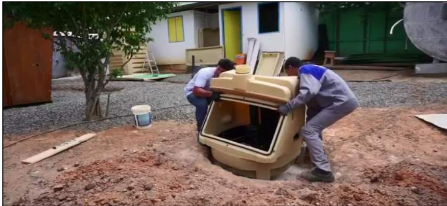
Colocar a unidade funcional em cima da camada.
