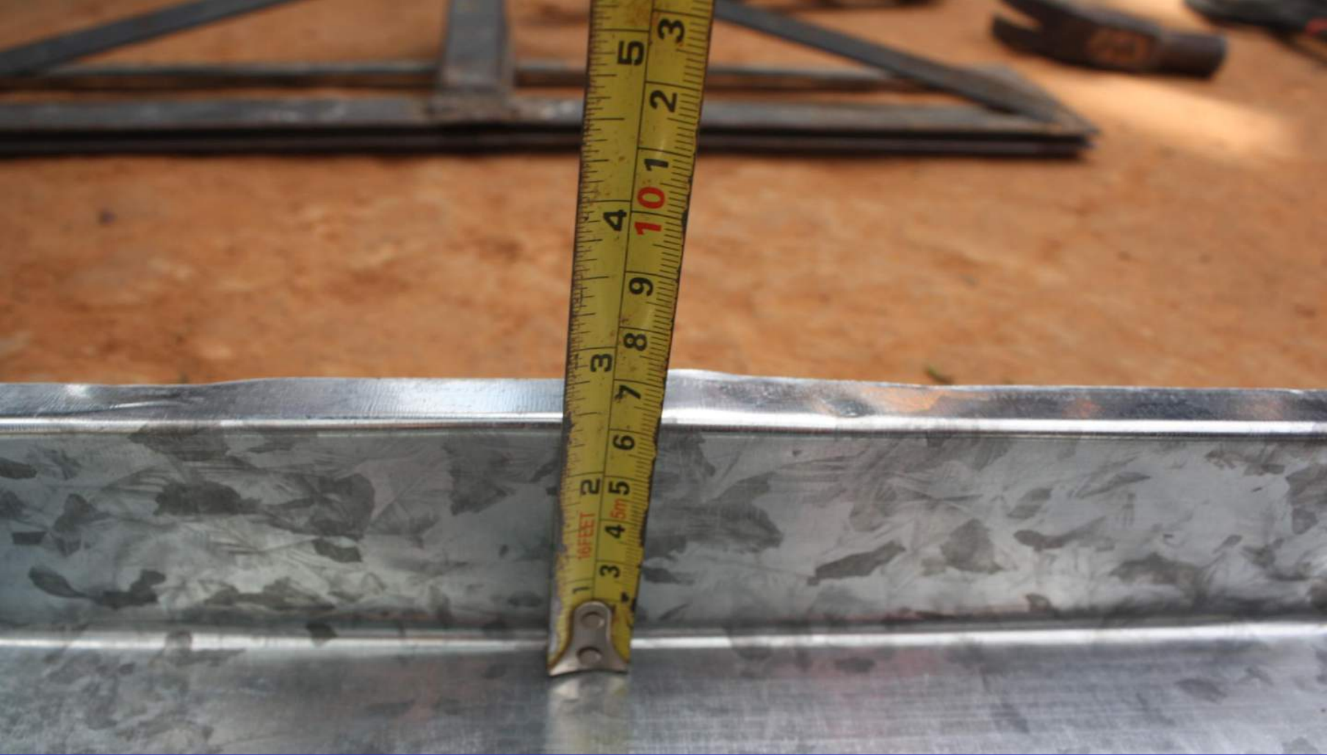
Medida da Altura da Calha (06 cm)
