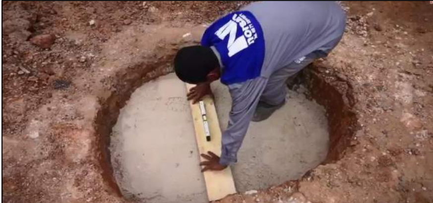
Nivelar o buraco com uma camada de areia.
