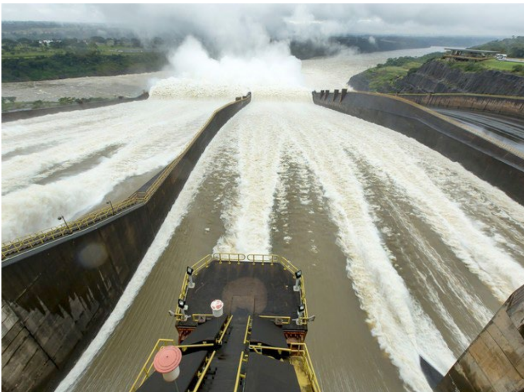
Figura 37. Formação de ondas estacionárias de frente abrupta na barragem de Itaipu. Vista lateral e vista de montante. Fonte: SBB, Engenharia / Banco de Imagens ANA
