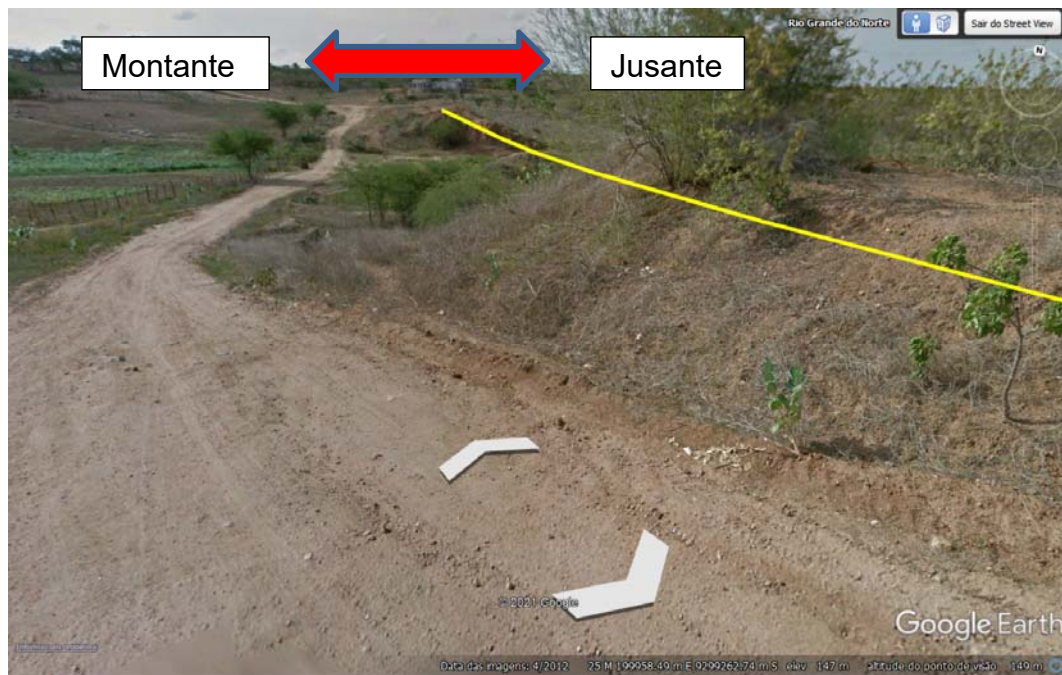
Imagem 01: Local do antigo barramento
