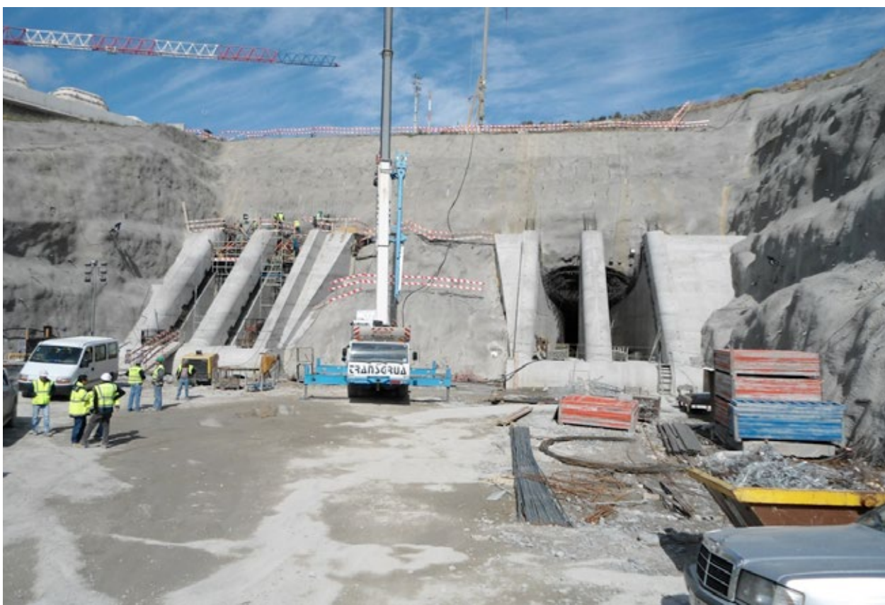
Figura 36. Tomadas de água numa das vertentes seguida de túnel. Barragem do Baixo Sabor, Portugal. Fonte: Coba, S.A. / Banco de Imagens ANA
