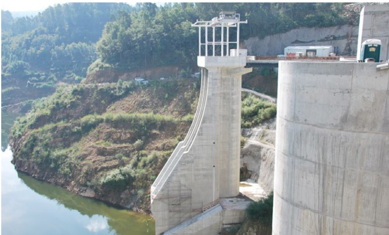
Figura 35. Tomada de água em torre, adjacente à barragem de concreto. Barragem de Ribeiradio, Portugal. Fonte: Coba, S.A. / Banco de Imagens ANA
