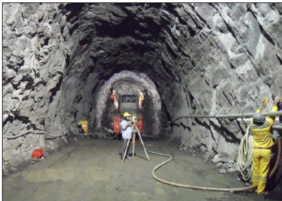
Figura 4.8: Imagem Ilustrativa de Escavação Subterrânea Executada pelo Método NATM.
