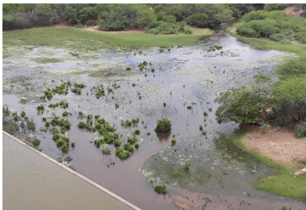
Foto 4.5 – Jusante da Barragem
