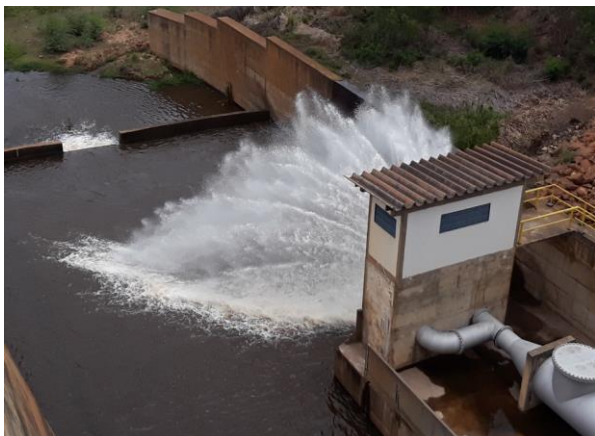
Foto 4.3 – Descarga por Válvula Difusora
