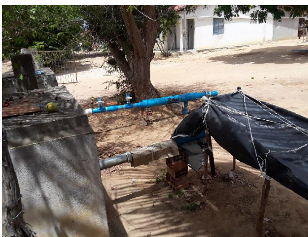
Foto 4.12 – Área Entrada de Lote
