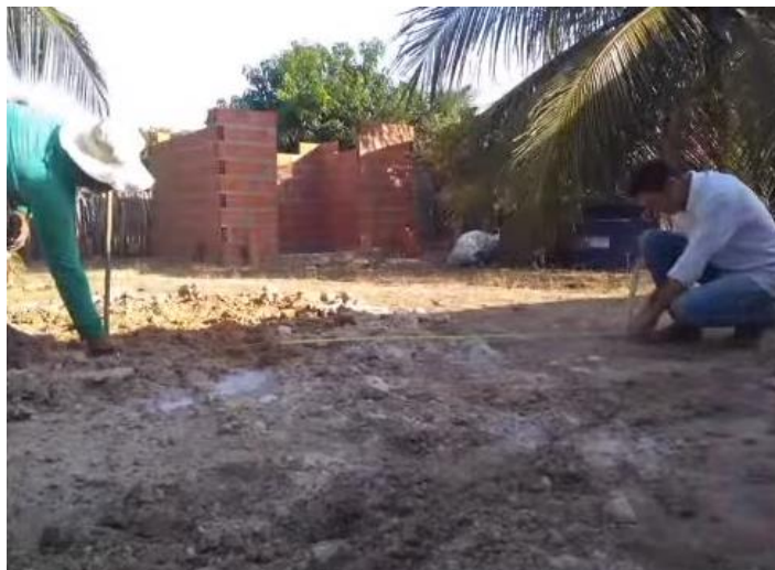
Figura 4: Demonstração da marcação do perímetro do tanque.
