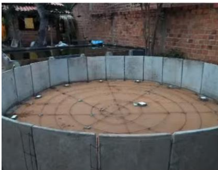
Figura 5: Demonstração da disposição das 24 placas.
