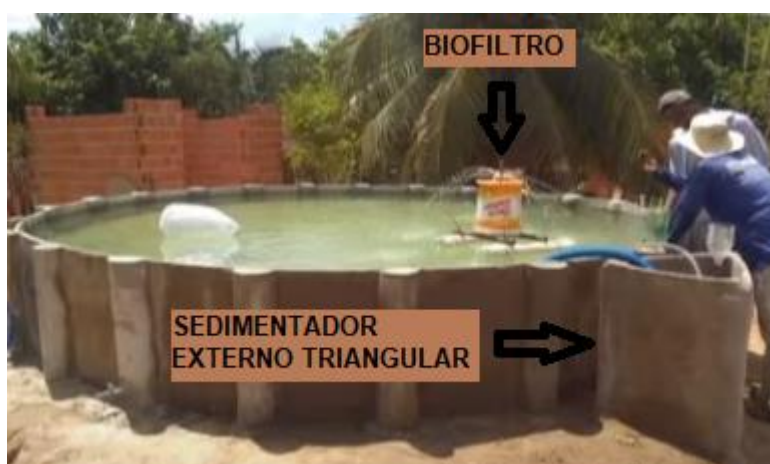
Figura 10: Demonstração do sedimentador e biofiltro.
