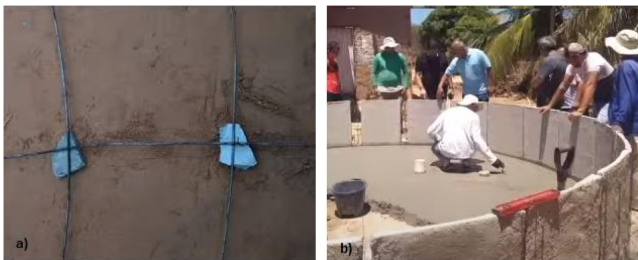
Figura 7: Detalhe da colocação dos calços de 2 cm e concretagem do fundo do tanque.
