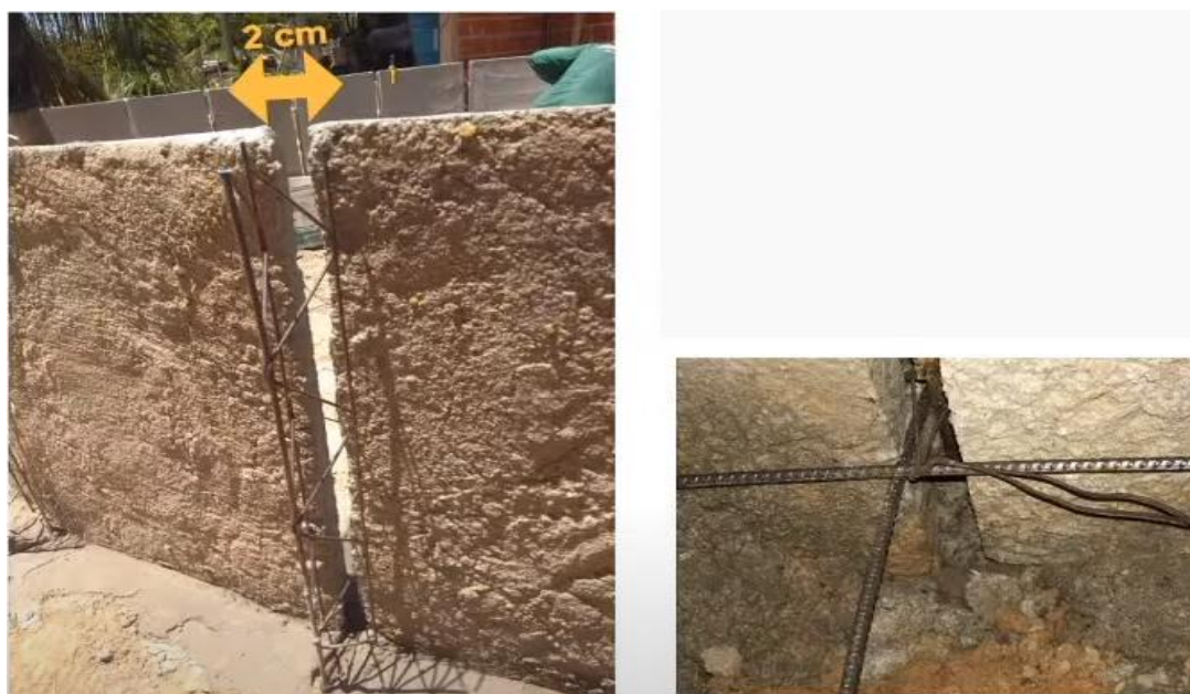
Figura 6: Demonstração da distância entre placas e utilização da treliça.
