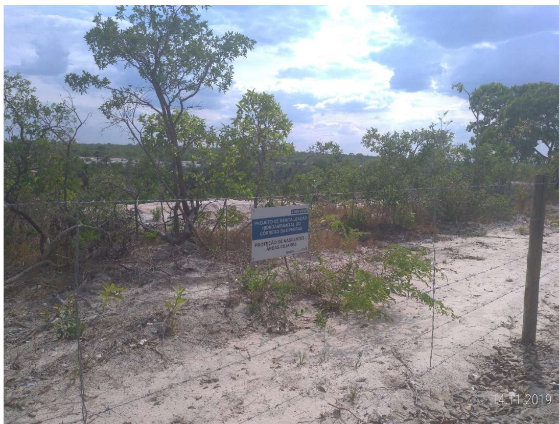
Figura 3: Modelo do cercamento de arame farpado, estaca a cada 6 metros e balancim.
