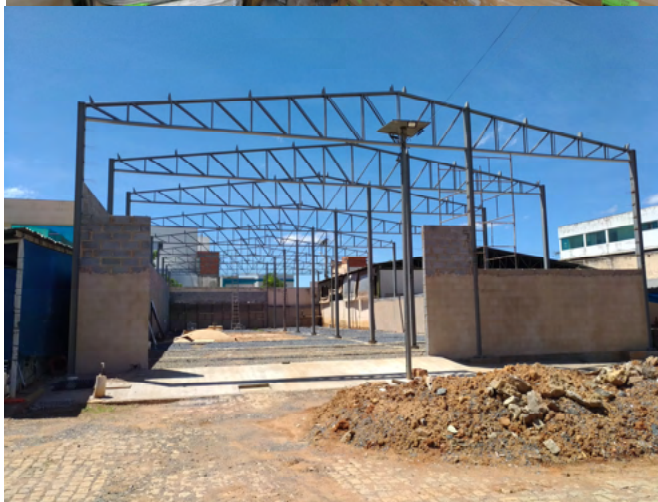
(galpão em construção na sede da 1ªSR – Montes Claros)
