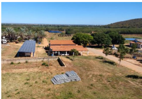
Foto 03. Entrada da 1ª/CIG e via de acesso.
