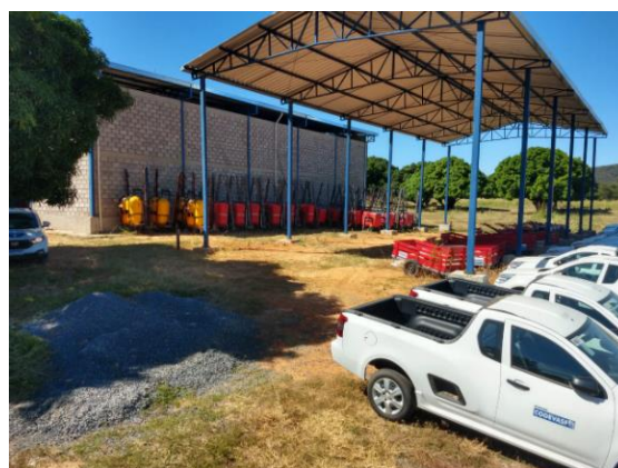
Foto 14. Galpões e pátio de armazenamento de equipamentos - 1ª/CIG.
