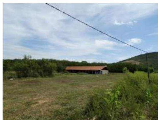
Foto 12. Galpão de armazenamento de materiais da 1ª/CIG.
