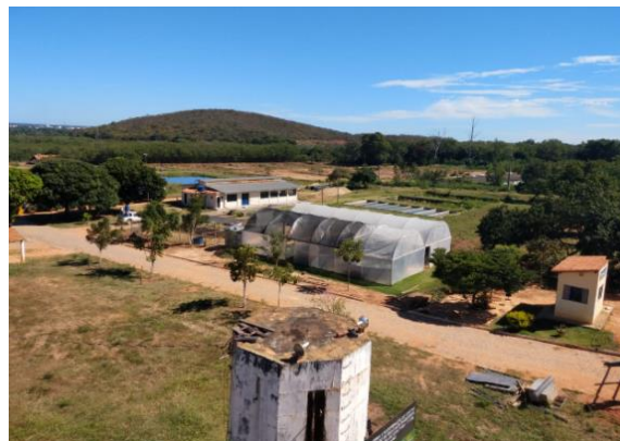
Foto 02. Entrada da 1ª/CIG com guarita e via de acesso.
