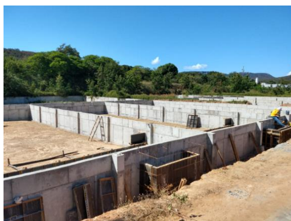
Foto 08. Tanques de concretos da 1ª/CIG.
