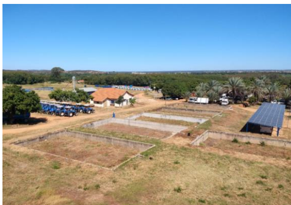
Foto 05. Usina fotovoltaica, laboratório, tanques de Alvenaria e prédio do Laboratório
