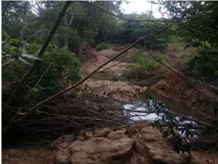
Foto 19: Ruptura do Dique do Rio Mosquito – Ponto DIQUE39 Coordenadas UTM 685.298 m E; 8.272.201 m S.
