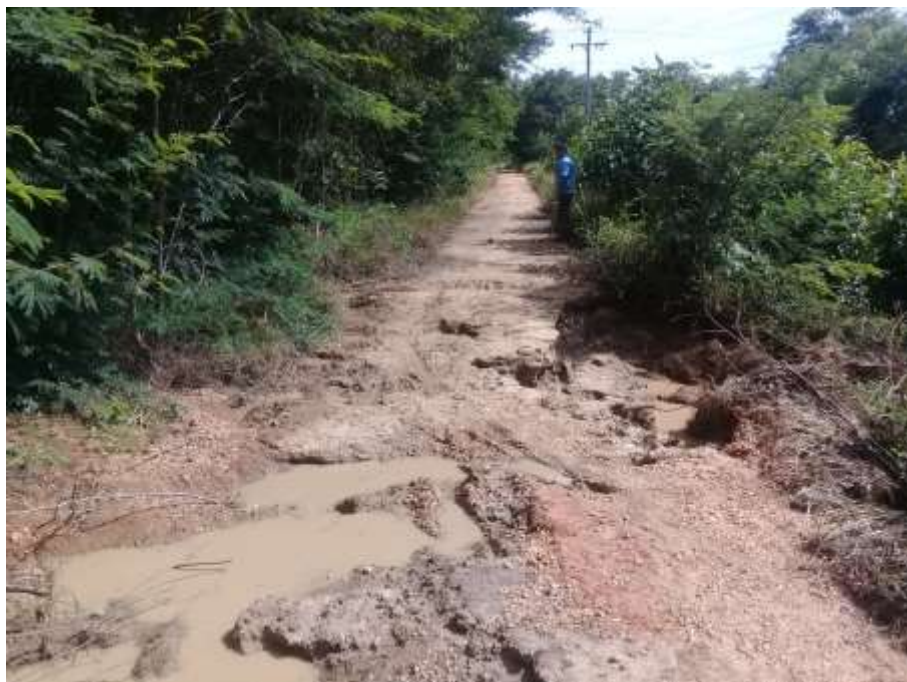
Foto 01: Erosão do Dique do Rio Mosquito – Ponto DIQUE1P Coordenadas UTM 685.016 m E; 8.269.711 m S.
