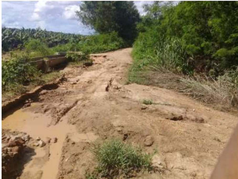
Foto 01: Erosão do Dique do Rio Mosquito – Ponto DIQUE1P Coordenadas UTM 685.016 m E; 8.269.711 m S.
