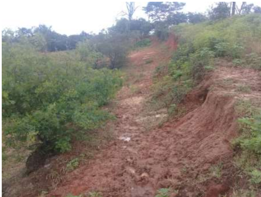
Foto 21: Área com jazida de material para reconstrução do Dique.
